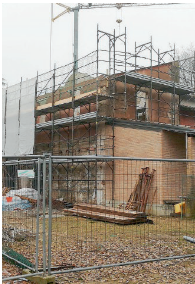
VILLA SORAGNA Un cantiere particolarmente impegnativo.
