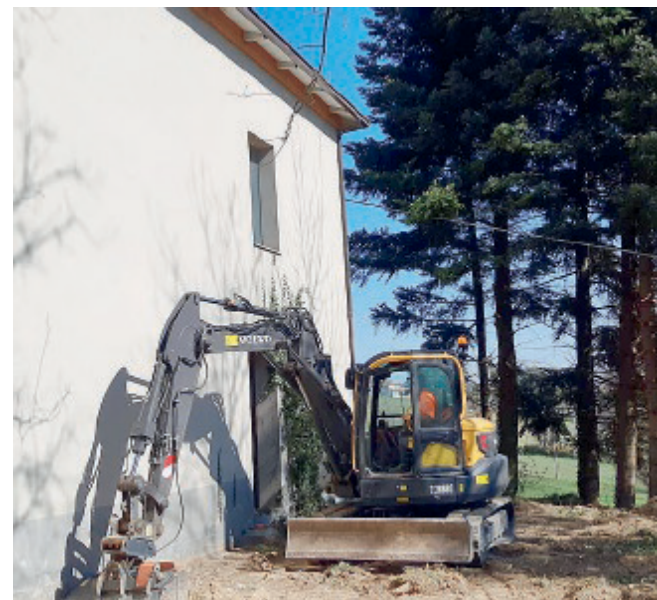
LIFTING Presto verranno anche piantati pali in profondità.
