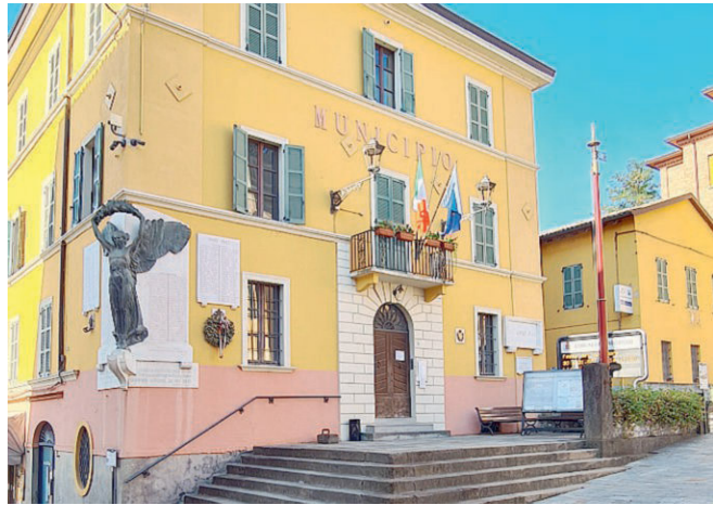
Scale da rifare Da ieri gli utenti degli uffici posti al primo e secondo piano dovranno utilizzare l'ascensore.
